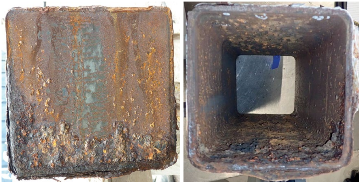
Figuur 9: Bij het bovenste knooppunt van spant 40 vertoont het onderste deel van de kopplaat (linkerfoto) en van de regel (rechterfoto) zware corrosie. (Bron linker foto: Onderzoeksraad voor Veiligheid. Bron rechter foto: SGS INTRON B.V.)
