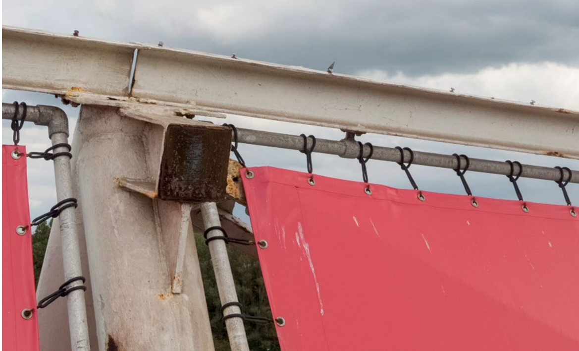
Figuur 15: In 2019 was roest op verschillende plaatsen rondom de verbinding zichtbaar ondanks het schilderwerk uit 2015, zoals te zien op deze foto van het bovenste knooppunt van spant 40 genomen enkele dagen na de instorting. (Bron: Onderzoeksraad voor Veiligheid)
