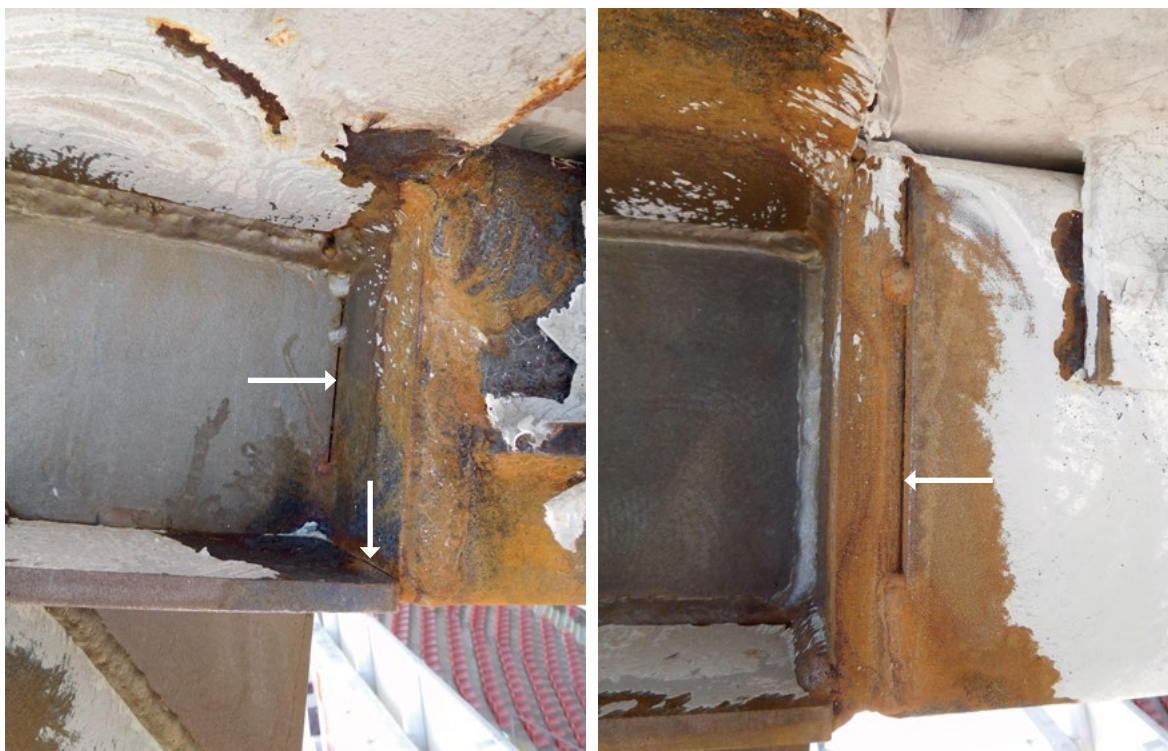
Figuur 13: Bij drie spanten (die niet bezweken zijn) ontbraken delen van lassen. Bij twee ging het om de verbinding tussen de kopplaat en het H-profiel (linkerfoto) en eenmaal om de verbinding tussen de kopplaat en de koker (rechterfoto). Voor het onderzoek is lokaal de verf verwijderd. (Bron foto's: Royal HaskoningDHV)
