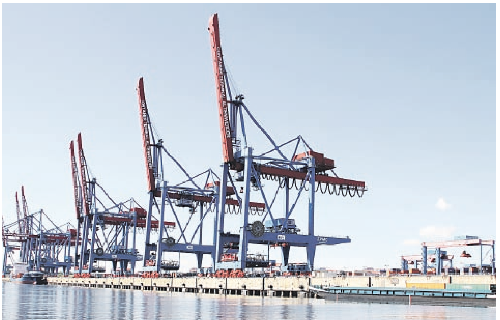
Containerterminal Altenwerder van de HHLA Hamburger Hafen und Logistik AG.
